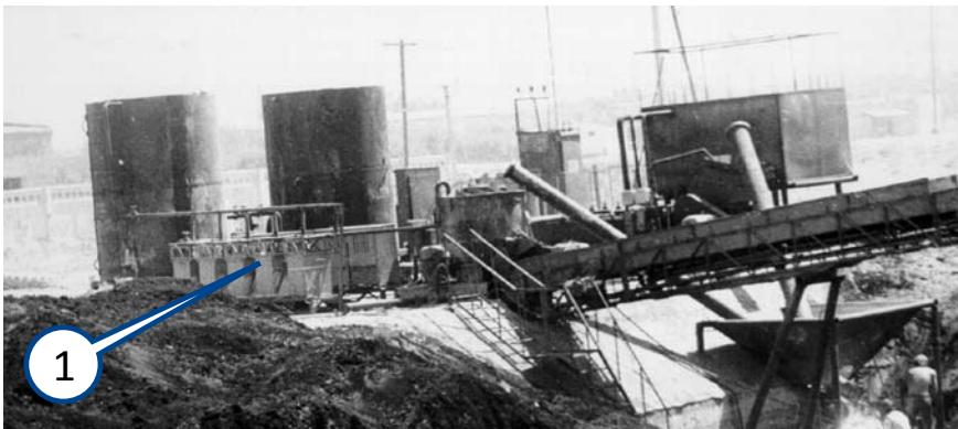
Рис. 2. Цех электрохимического синтеза гуматных реагентов (ЦЭСГР). Разработан и построен в 1980 г. в пос. Караул-Базар Бухарской области. Производительность цеха — 25 тонн пастообразного углещелочного электрохимически активированного реагента (УЩР-А) за смену. Гуматный реагент УЩР-А поступал на буровые Бухарского управления буровых работ и обеспечивал экономию по каждой скважине до 60 % всех средств на приготовление и обработку бурового раствора. Основное оборудование цеха — электрохимические реакторы для получения католита пластовой воды суммарной производительностью 10 м 3 /ч (1) и электрохимические реакторы для обработки пульпы реагента производительностью 2 м 3 /ч каждый (2).
