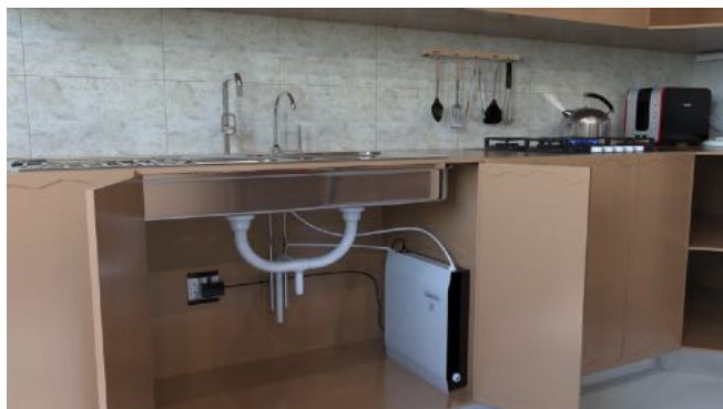
Рис. 6. Установка IZUMRUD-V3 с элементами МБ нового поколения, обеспечивающими наилучшую из достигнутых степень очистки и кондиционирования питьевой воды, 60 л/ч, 2017 год.
